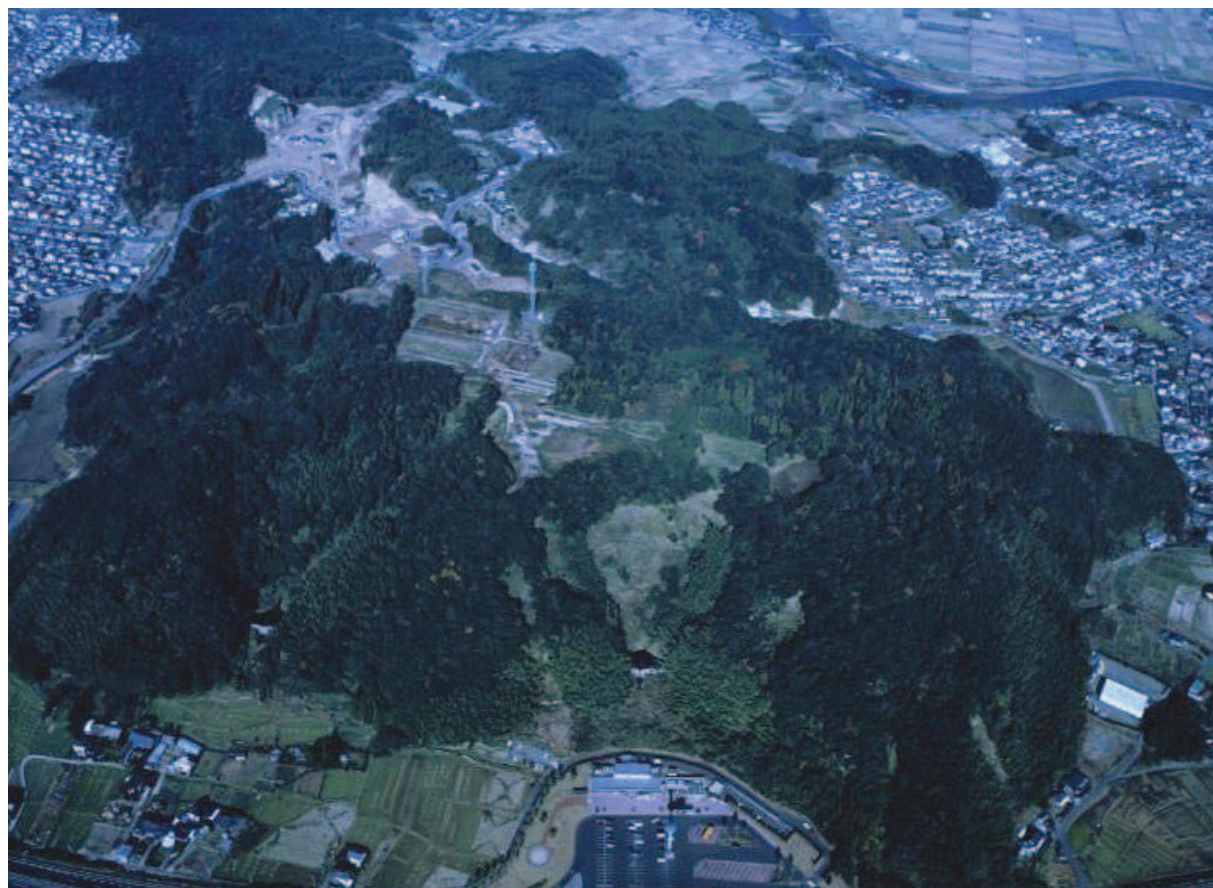
建昌城跡 全景（南東から）
