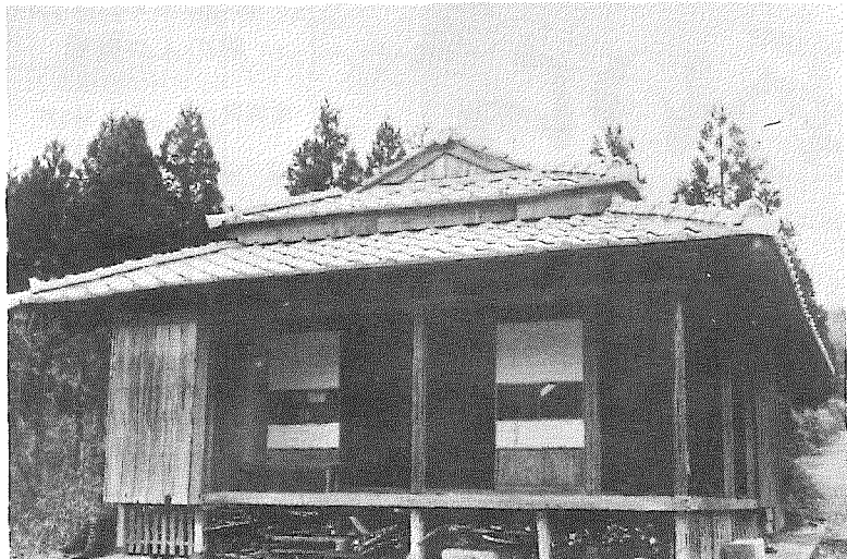
完成した北野部落公民館
