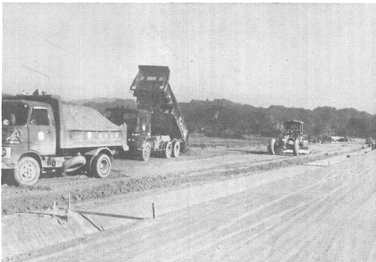
着々と進む高速道路工事 (森部落付近で)
