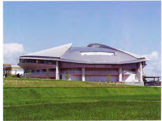
蒲生町総合体育館(おおくすアリーナ)完成
