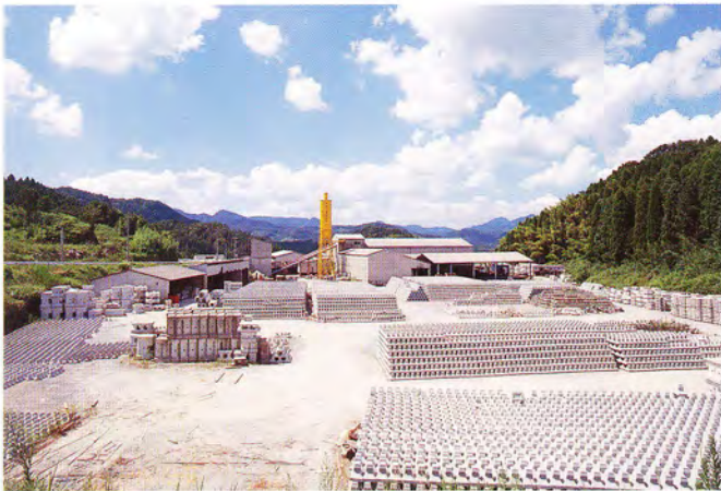
鹿児島共和コンクリート工業(昭和63年)
