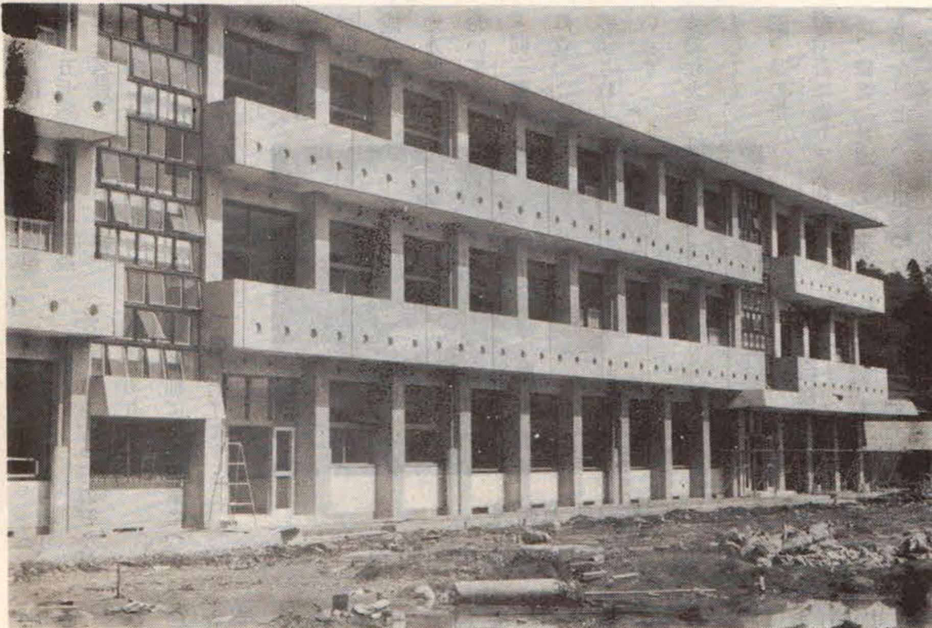
昭和43年7月着工された統合中学校の第1期工事は、普通教室14室、特別教室3室、その他管理室など、延3,143m<sup>2</sup>、工費9,717万円で、税所組の施工により、3月末の完成をひかえ、最後の仕上げが急がれています。
