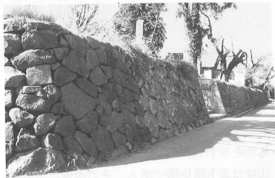
帖佐館跡石垣(東面・大手口)
