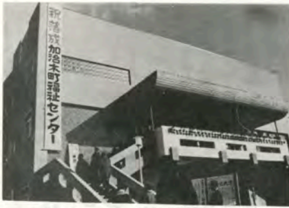
福祉センターの建設事業
