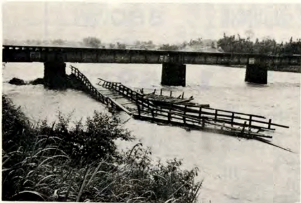
鉄橋にひっかかった田中橋
