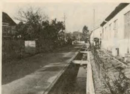
→整備された排水溝（田中）
