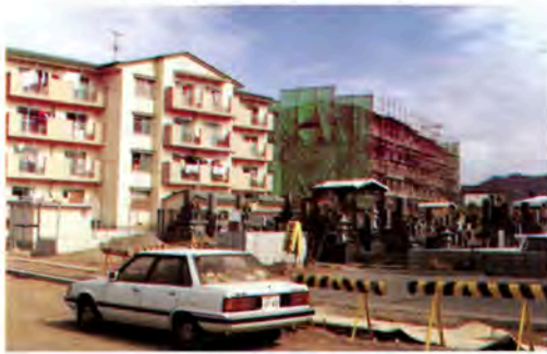
完成間近の町営住宅
