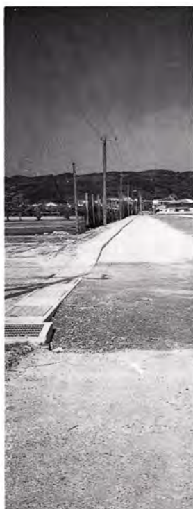
整備が進む木田振興地区
