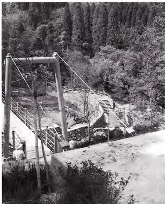
整備の進むかじかの橋周辺
