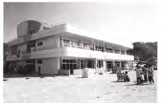
3階建てのデイ・サービスセンター
