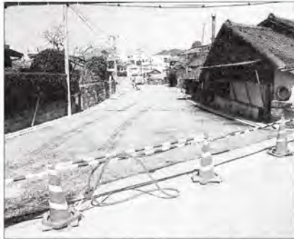
一部改修終わった垂之口川
