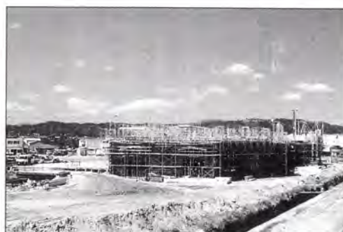
工事が進む始良衛生処理場
