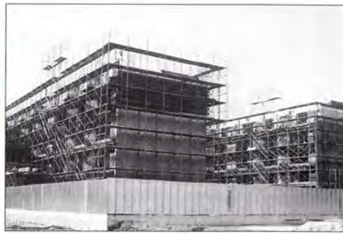
急ピッチで工事が進む雇用促進住宅
