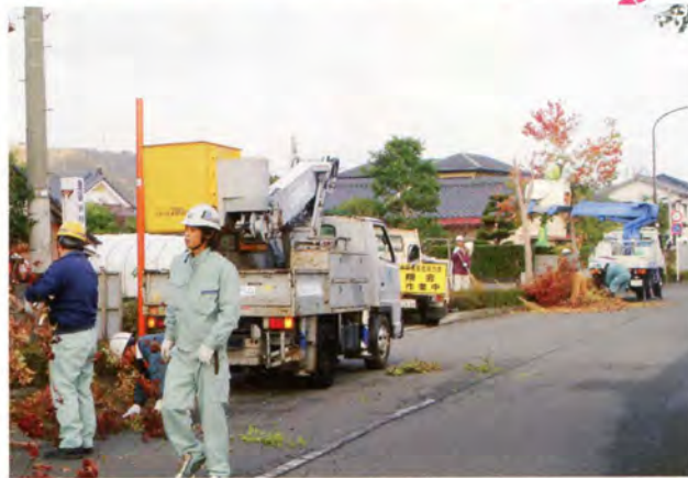
第一建設(株)安全衛生協会「木翔会」のメンバーが 街路樹をきれいに伐採しました
