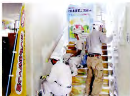
側壁の塗り替え作業
