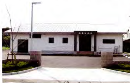
完成した岩原公民館
