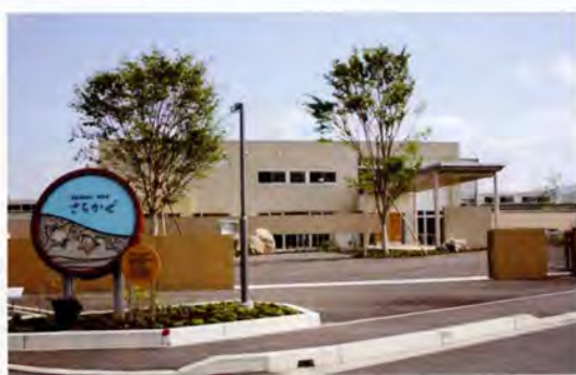
障害者支援施設さちかぜの正面入り口
