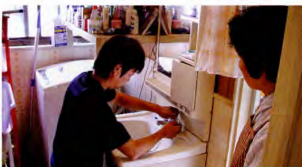
手際よくパッキン取り替え
