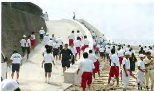
海岸から堤防に階段とスロープで行き来できるようになりました
